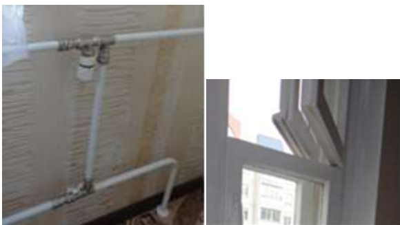
Рисунок 4 Байпас и открытое окно для регулирования температуры
