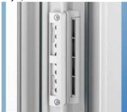
Рисунок 14 Искусственные отверстия между рамой и окном
