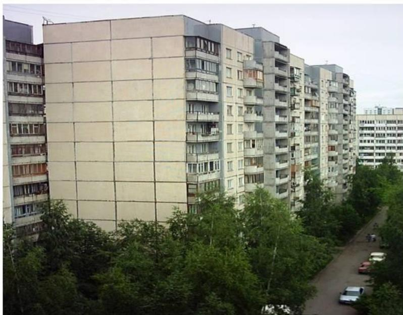
Рис. Жилое здание массовой крупнопанельной 137 серии
