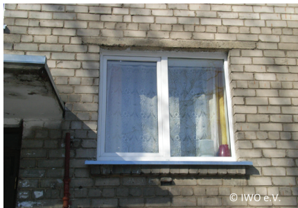
Рис. 2 и 3: Утепление отдельных помещений здания и замена одного окна.
